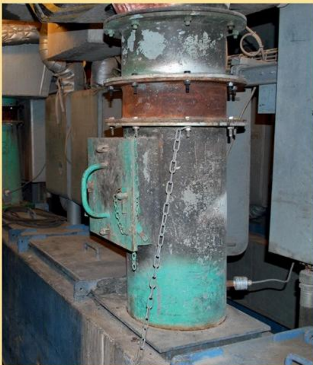
To af de 12 opsamlingsstragte, der er placeret nede under forbrændingsristen.
